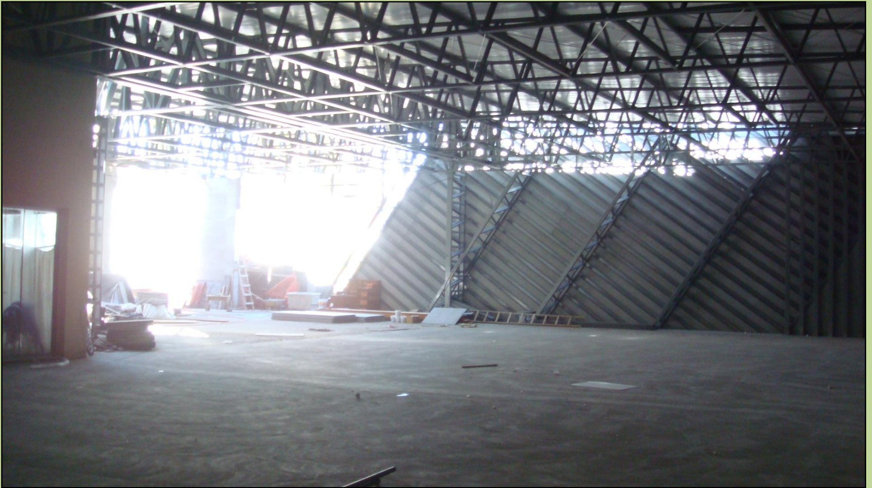
Figura 4. Construção Salão Carmenère
