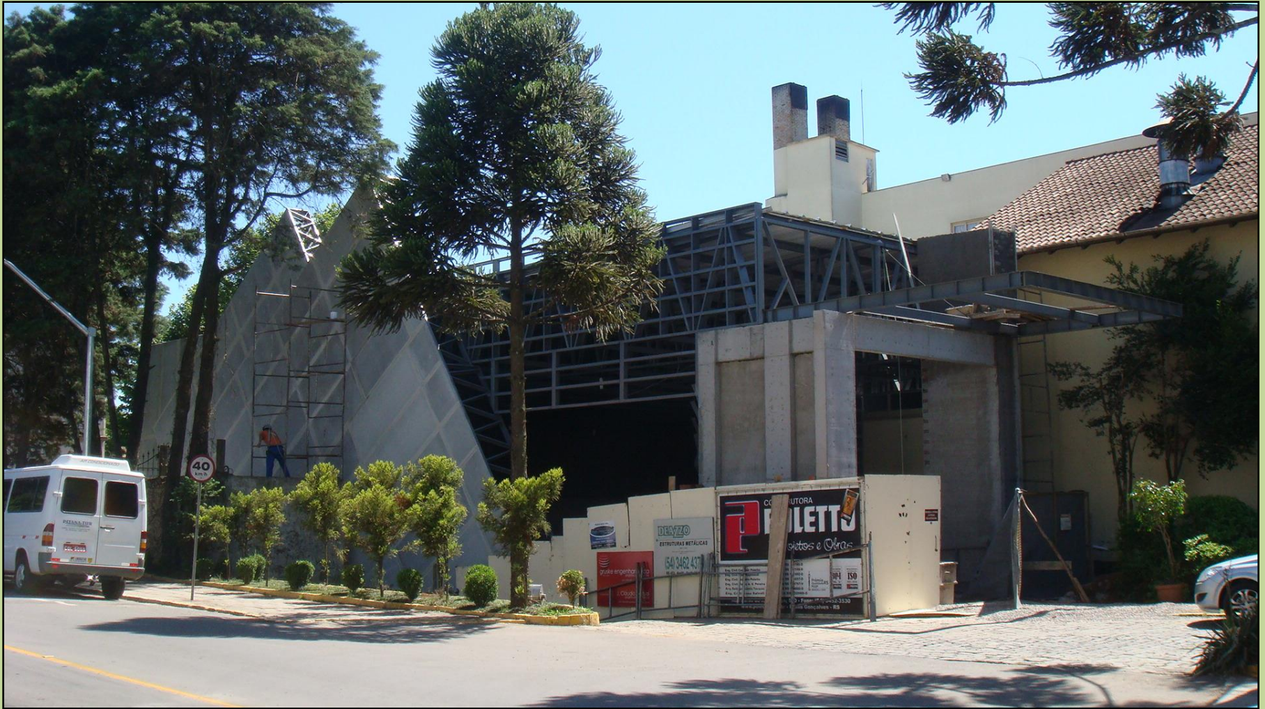
Figura 3. Construção Salão Carmenère
